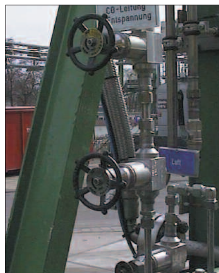
Modelo 2020 num tanque de descarga - isolamento de monóxido de carbono a alta pressão (225 bar) - Alemanha
